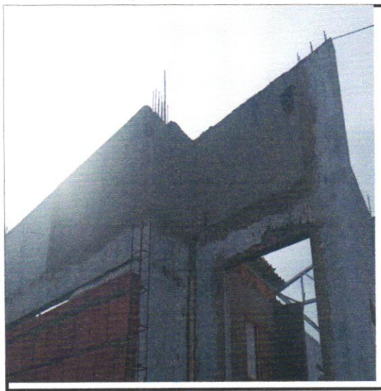
FOTO - 06 - MASSA ÚNICA, EM ARGAMASSA INDUSTRIALIZADA, PREPARO MECÂNICO, APLICADA COM EQUIPAMENTO DE MISTURA
