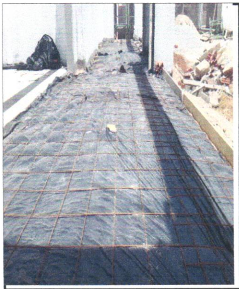
FOTO - 27 - Passeio em concreto
