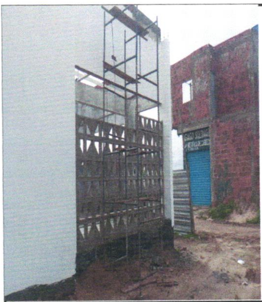
FOTO - 18 - APLICAÇÃO MANUAL DE MASSA ACRÍLICA EM PANOS DE FACHADA
