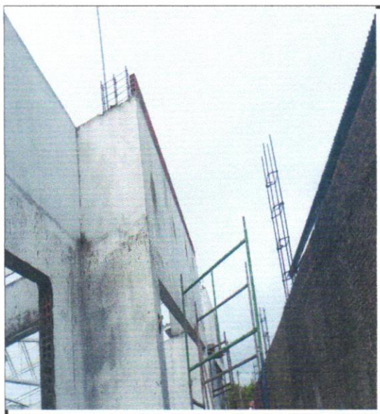
FOTO - 22 - ALVENARIA DE VEDAÇÃO DE BLOCOS CERÂMICOS FURADOS NA VERTICAL DE 14X19X39CM (ESPESSURA 14CM) DE PAREDES
