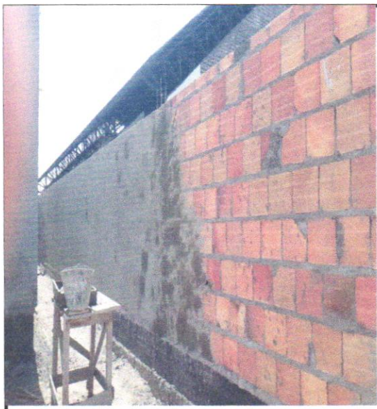
FOTO - 32 - ALVENARIA DE VEDAÇÃO DE BLOCOS CERÂMICOS FURADOS
