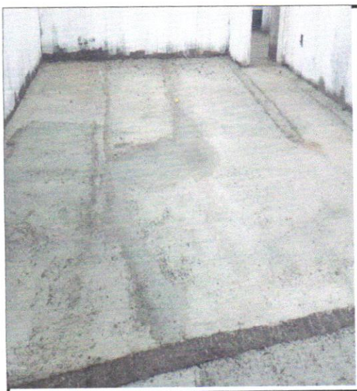
FOTO - 10 - CONTRAPISO EM ARGAMASSA TRAÇO 1:4 (CIMENTO E AREIA), PREPARO MECÂNICO COM BETONEIRA 400 L, APLICADO
