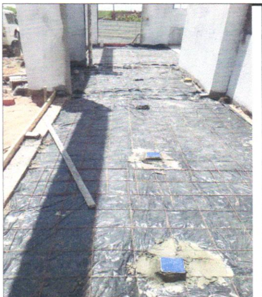
FOTO - 31 - Passeio em concreto
