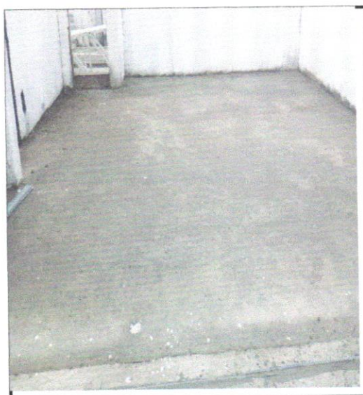
FOTO - 12 - Passeio em concreto
