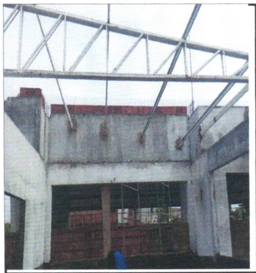
FOTO - 05 - TRAMA DE AÇO COMPOSTA POR TERÇAS PARA TELHADOS DE ATÉ 2 ÁGUAS PARA TELHA
